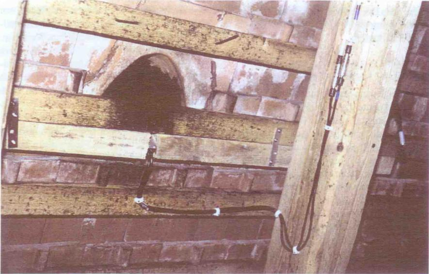
Abb. 3. Infrarotlichtschranken unterhalb der Ausflugziegel. Durch paarweise Anordnung läßt sich zwischen Aus- und Einflug unterscheiden. Aufn.: M. KLINGER
